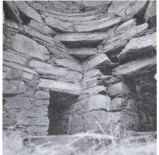
Fig. 22 サンガオのドーム架構 Dome in Sanghao
